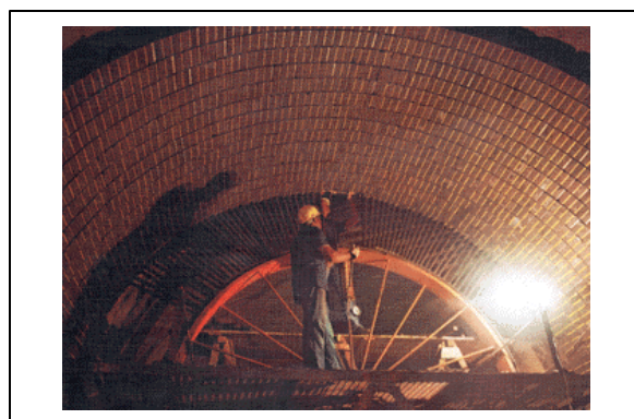
Figura 28. Revestimento Básico em Forno de Cimento
