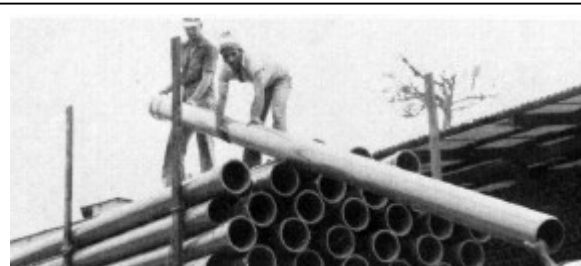
Figura. 01. Carga em caminhão
