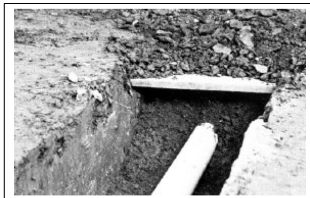
Fig. 13. Tubulação Enterrada
