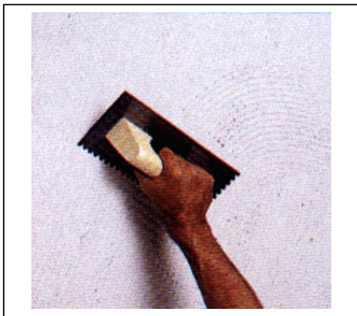
Figura 20. Espalhamento da argamassa de assentamento
