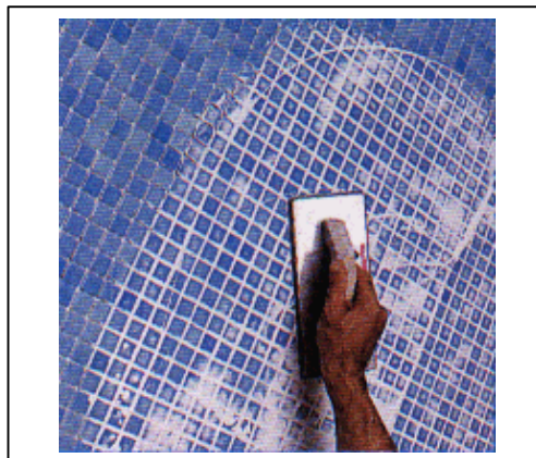
Figura 26. Aplicação da pasta de rejuntamento
