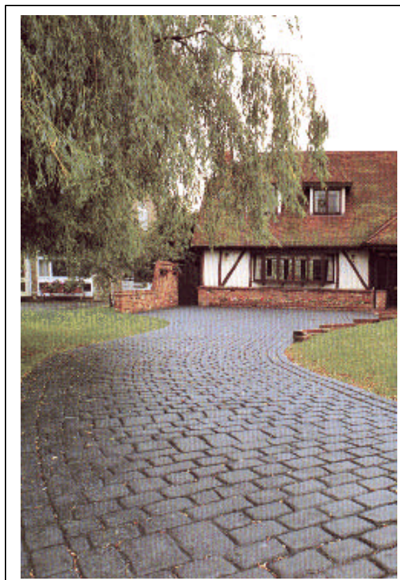
Figura 01. Pisos em concreto estampado
