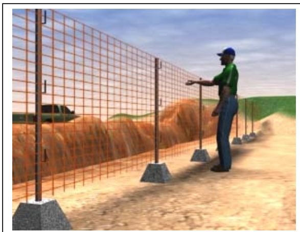
Fig. 01. Proteção de vala com tela de PVC
