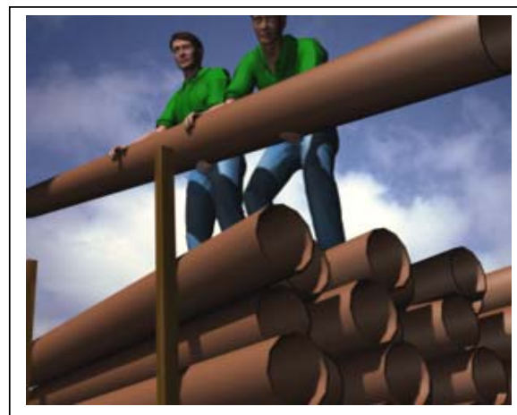
Fig. 01. Descarga manual de tubos de PVC
