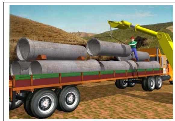
Fig 01. Descarregamento dos tubos
