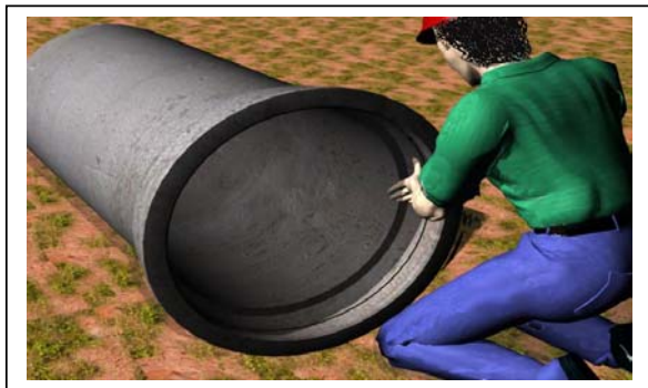
Figura 2 - Lubrificação do anel de borracha
