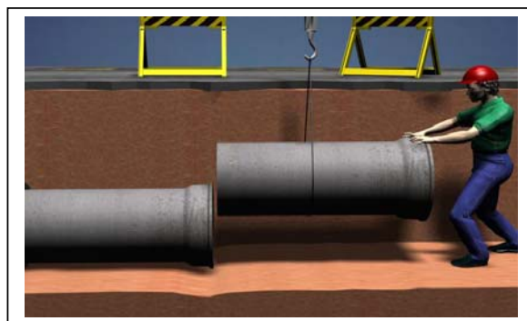
Figura 3 – Acoplamento de tubos de concreto
