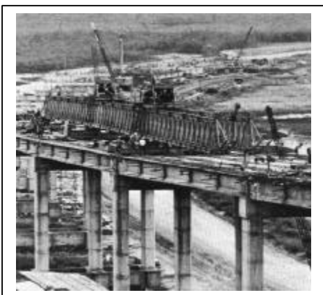
Figura 15 – Cimbramentos com Treliças Autolancáveis
