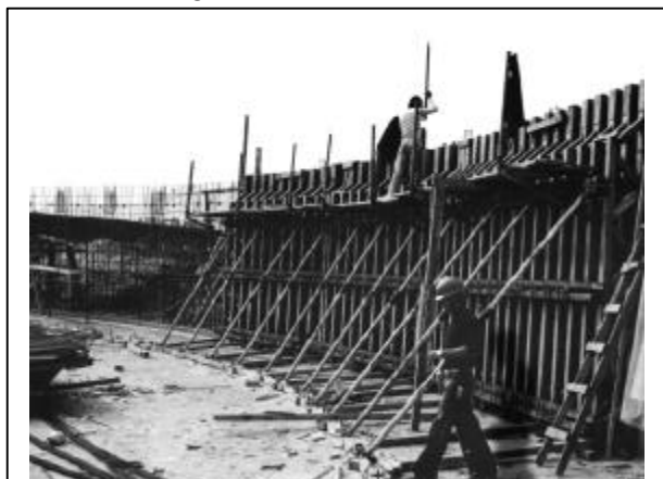
Figura 21 - Execução de Cimbramento para Formas Verticais
