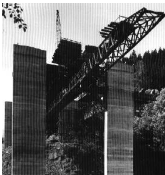
Figura 14 – Cimbramento para Avanços Sucessivos
